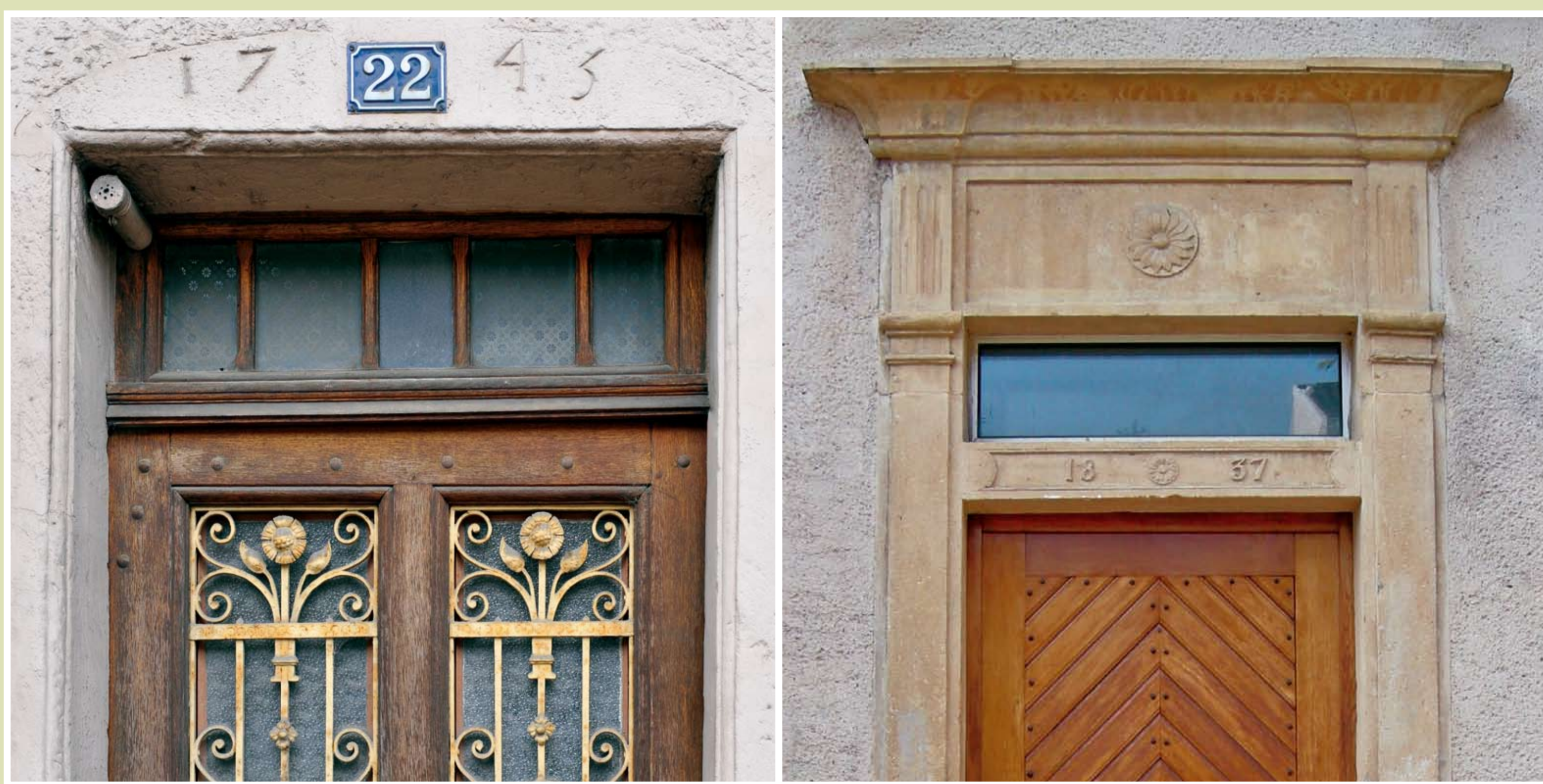
Détail du 22 rue de Verdun, porte piétonne avec linteau daté 1745
